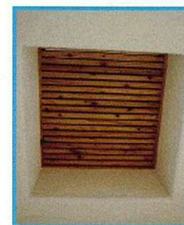
1階と2階の通路に設置された自然換気システム
